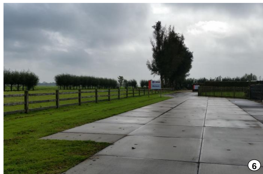
6. Harde gebiedsvreemde verharding als huidige terrein ontsluiting
