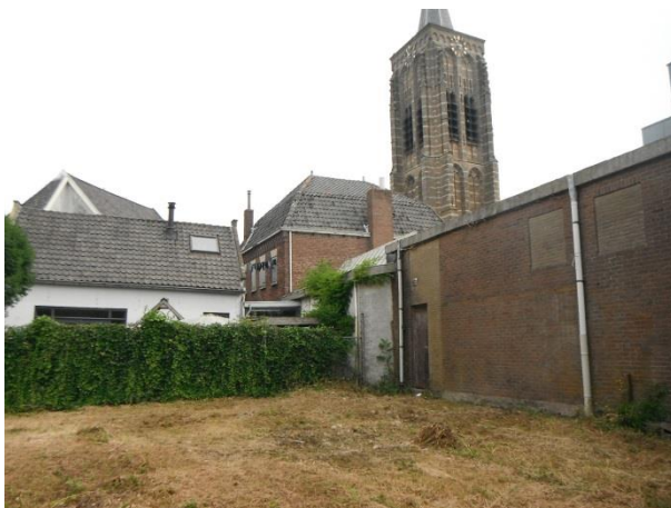
Achterzijde loods met zicht op woning en grasland
