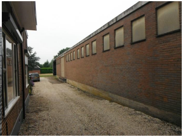
De loods richting het zuiden gezien (bj. 1962)
