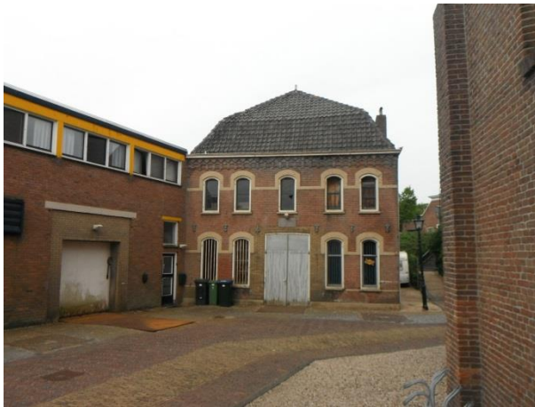
Te renoveren woning (bouwjaar 1894)
