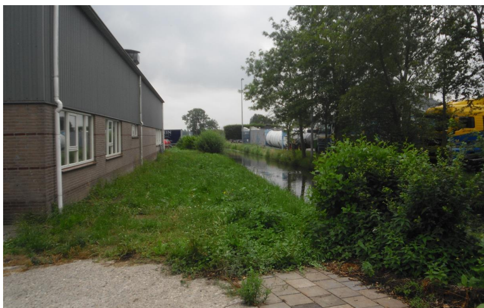
Afbeelding 16: Afstand tussen bestaande loods en naastgelegen watergang
