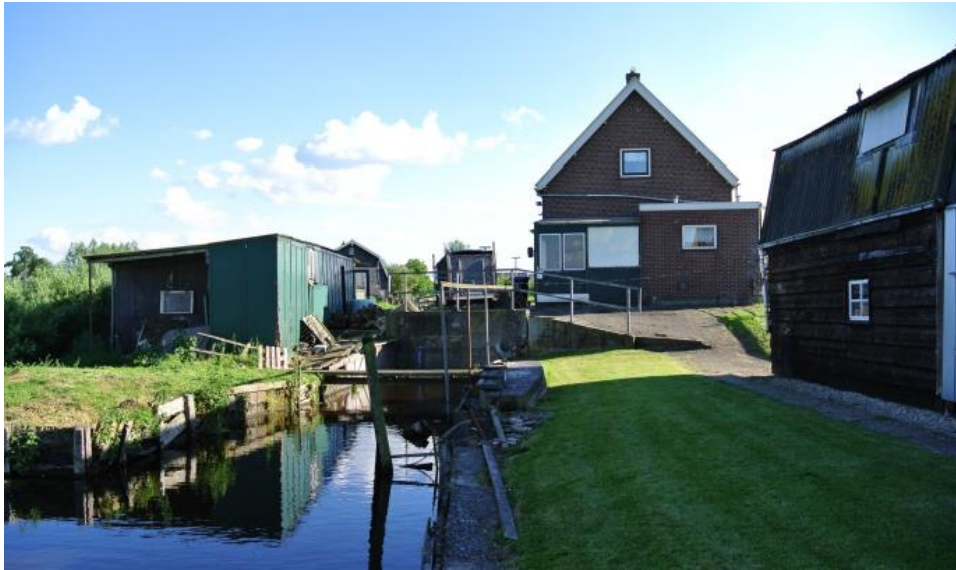
Afbeelding 7: Bestaande situatie (achterzijde woning Heulenslag 8)
