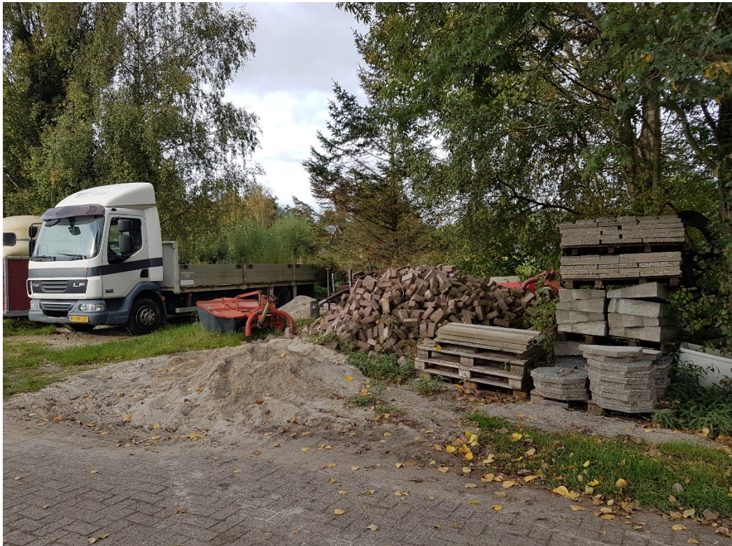
Figuur 6 Bomen en materiaalopslag ter hoogte van de nieuw te graven waterpartij.
