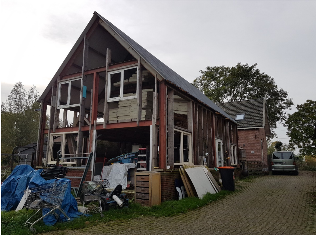
Figuur 3 Schuur in aanbouw ten oosten van de woning. De schuur en het terrein voor de schuur worden gebruikt voor opslag van materiaal.
