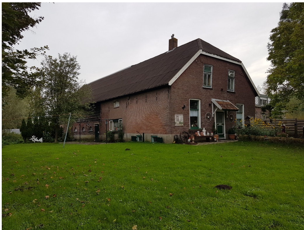
Figuur 1 Het te renoveren woonhuis op de planlocatie aan Heulenslag 39 te Bleskensgraaf.
