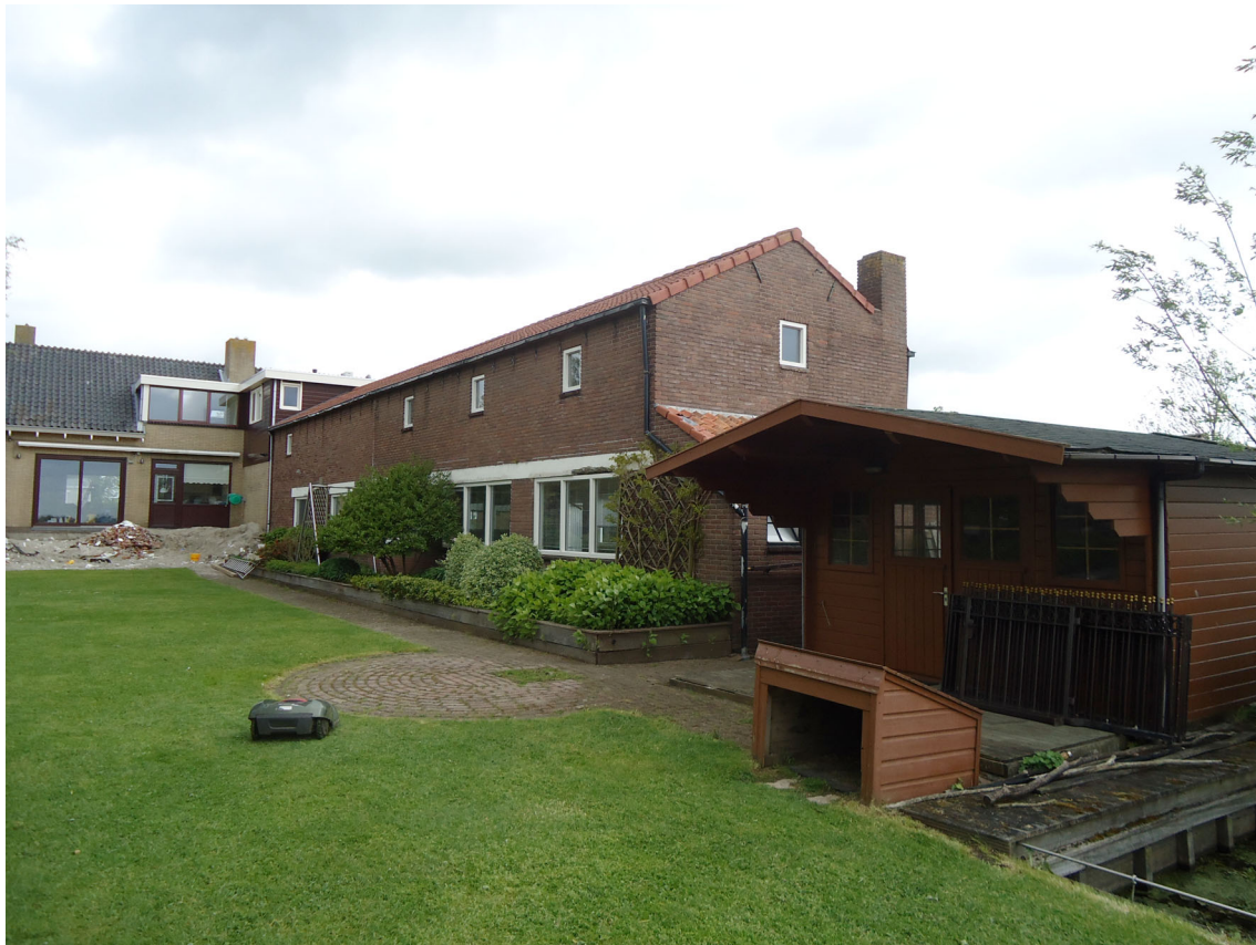
Foto Links op de foto het te behouden bedrijfspand/woning, midden de te slopen bebouwing en rechts de te behouden blokhut.
