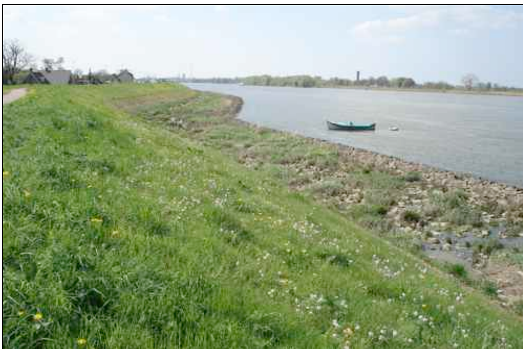
Figuur 2.3 Lekdijk met oever van basaltstenen
