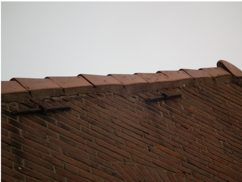
Figuur 4 Onder andere de kant- en nokpannen zijn afgedicht met specie in bevatten geen openingen die mogelijk een toegang tot verblijfplaatsen van vleermuis en/of gierzwaluw bieden.
