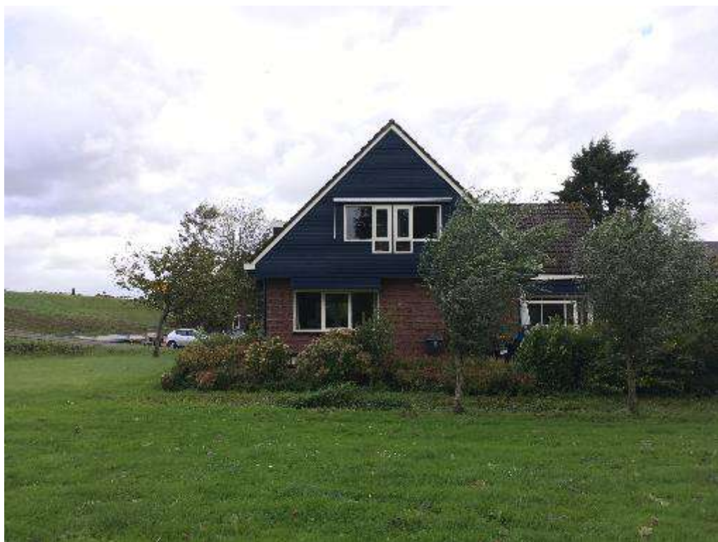
Figuur 1 De bedrijfswoning is opgetrokken uit gemetselde muren. De tweede bouwlaag bestaat uit rabathoutdelen. De woning is bekleed met een pannendak.
