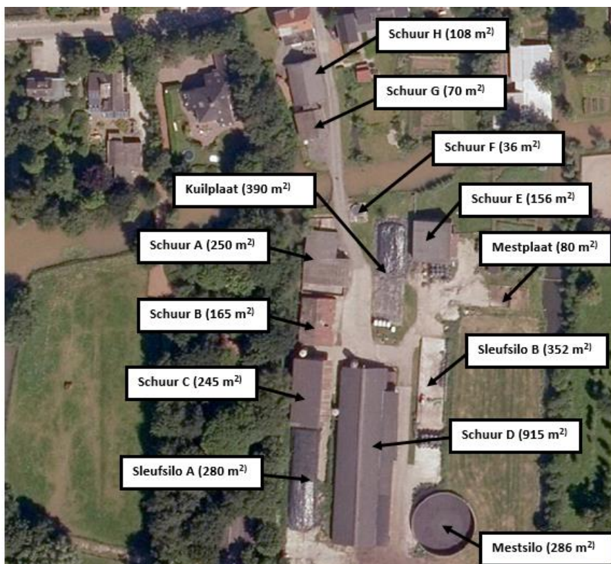
Afbeelding 3: Overzicht agrarische bedrijfsbebouwing Abbekesdoel 28 (deelgebied 1)
