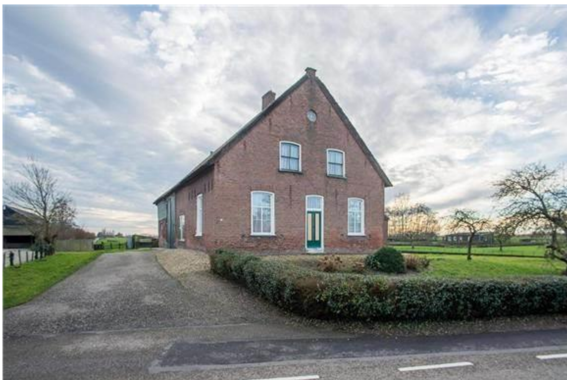
Afbeelding 3: Vooraanzicht bestaande boerderijgebouw
