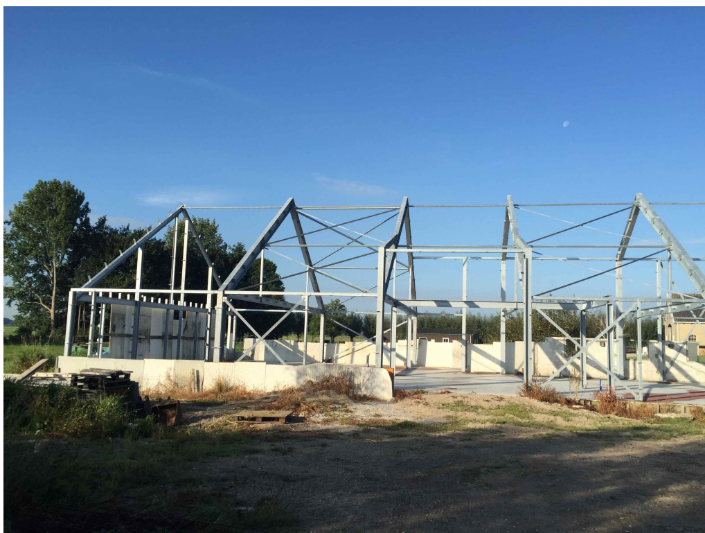
Figuur 2 De schuur ten zuidwesten van de woning is in aanbouw en bestaat thans slechts uit een betonvloer enkele muren en stalen spanten.
