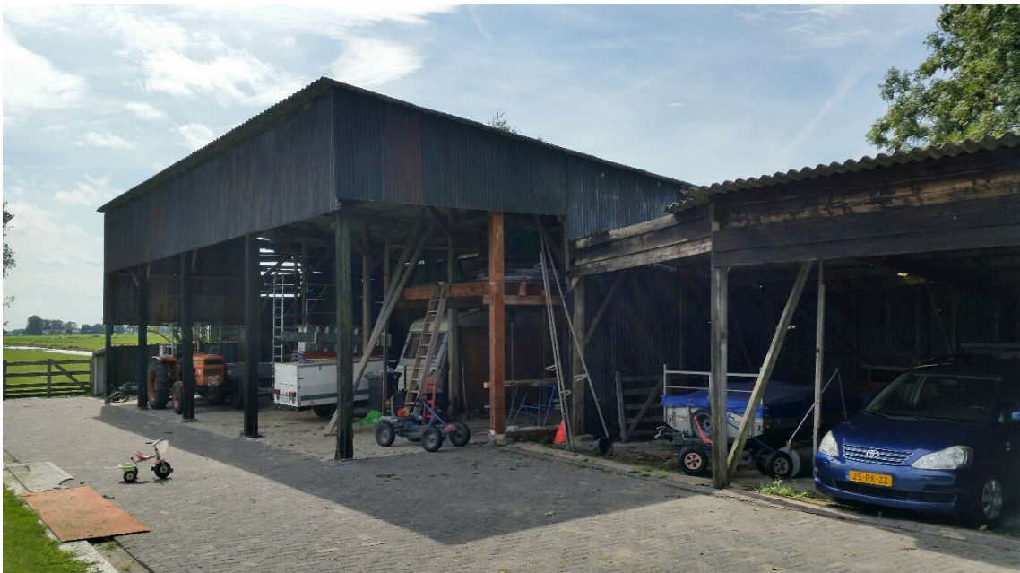
Foto 2 Te renoveren kapschuren met asbestdak
