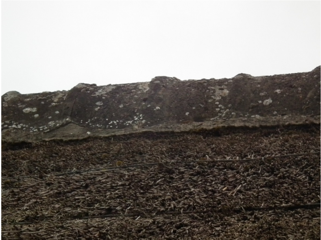
Figuur 3 Het dak van de te slopen woning is ongeschikt voor vleermuizen, huismus en gierzwaluw. De nokpannen en gevelafwerking sluiten nauw aan op de gevels en het rieten dak.
