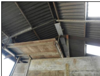
Figuur 10. Vliering kapschuur.
