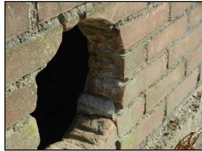
Figuur 5. muur melkveestal, enkelsteens.
