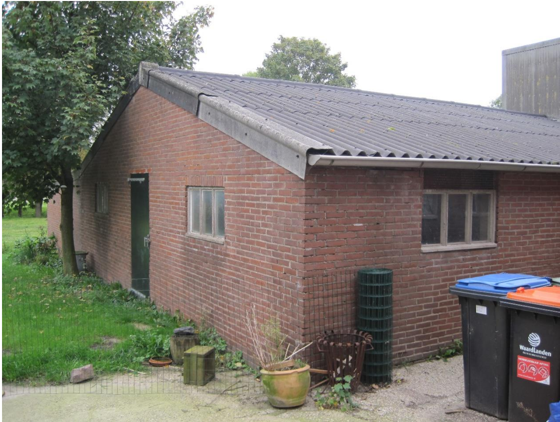
Afbeelding 15: Te slopen varkensschuur
