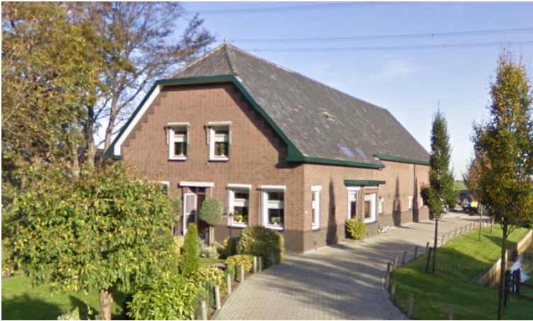
Heulenslag 52 Bleskensgraaf 1931, architect P.D. Stuurman.
