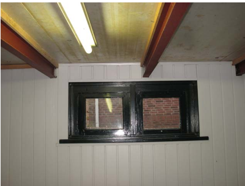
Ruimte 2b _ kelder De binnenzijde van de keldervensters. Door het venster is het pand van de burens te zien.
