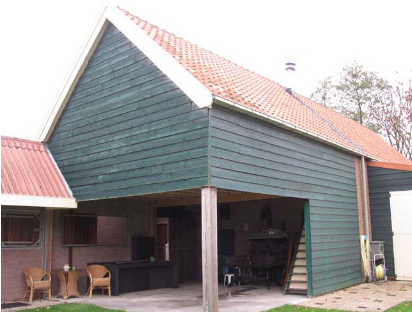
Achtergevel van de voormalige varkensschuur (1) met tasruimte (3). De trap naar deze ruimte is afkomstig uit de boerderij.
