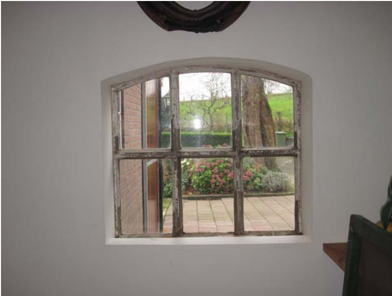
Een betonnen stalvenster in de voormalige varkensstal.
