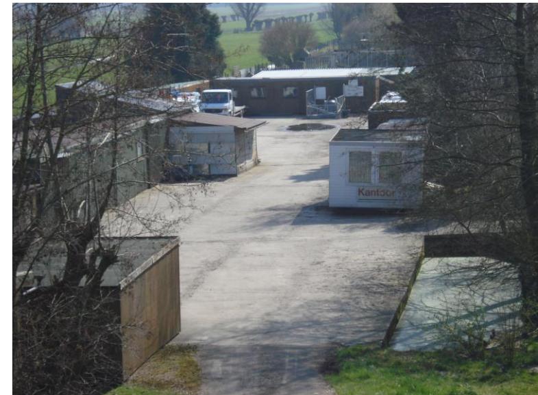
Afbeelding 6: bestaande situatie Lekdijk 13, een verrommelt perceel
