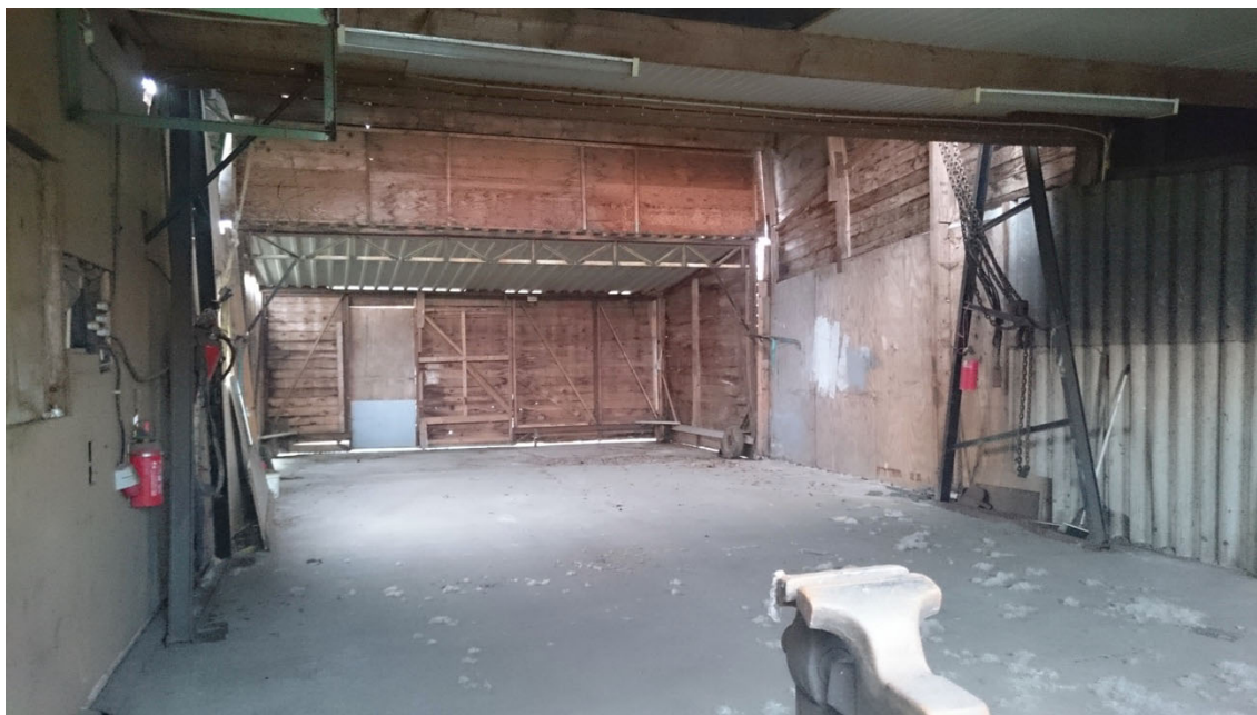
Foto 4 Bedrijfsgebouw C met invliegopening (niet op deze foto zichtbaar).
