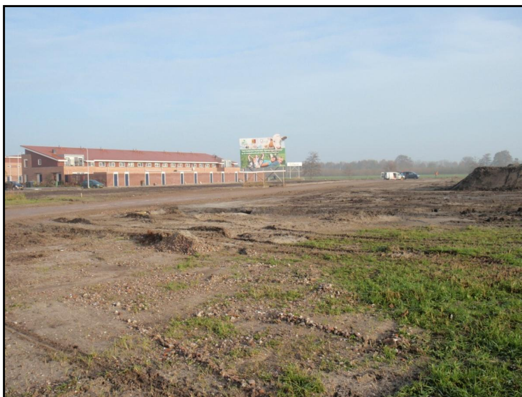
Figuur 6: Foto genomen vanuit de zuidwesthoek, vanaf de brug leidend naar het Graafland.
