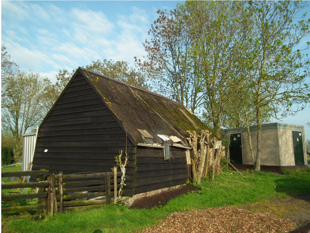
Figuur 3 Ten behoeve van de voorgenomen ontwikkeling wordt een schuurtje gesaneerd. De schuur is opgebouwd uit een vorstrand met houten muren met een golfplaten dak.
