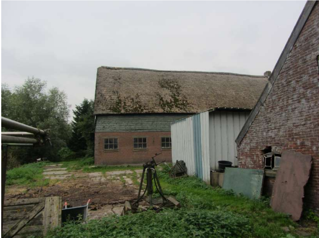
Figuur 3 Schuur en unit (rechts) op het terrein aan de noordzijde van het Achterland ter hoogte van nummer 17.
