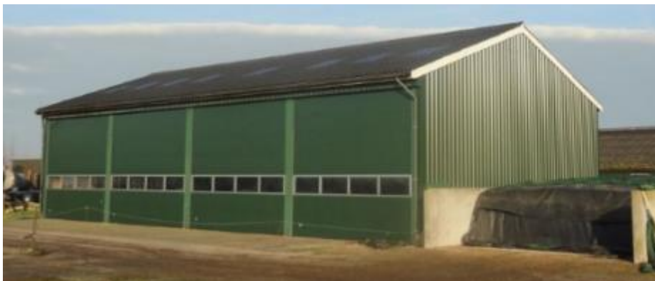
Afbeelding 4: Bestaande loods met naastgelegen sleufsilos
