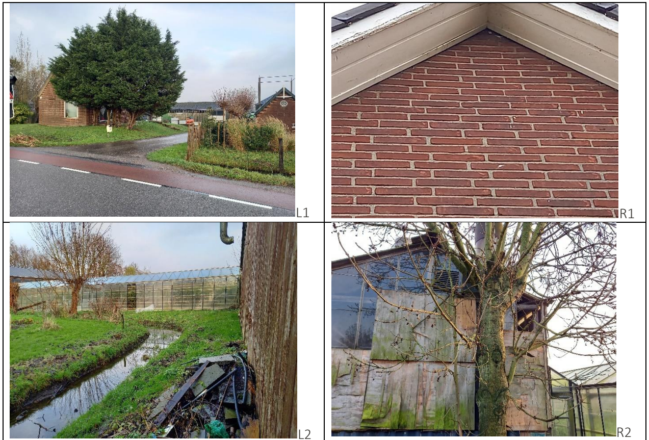
Figuur 4. Huidige situatie Nieuwkoopseweg 44a (L1 – Perceel vanaf de Nieuwkoopseweg, L2 – Puin, kasruiten missen, R1 – Daklijsten met ruimte, R2 – Beplating, om missende kasruiten af te dichten)
