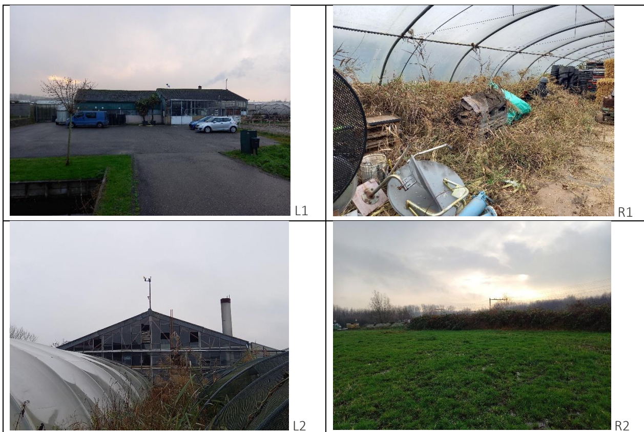
Figuur 3. Huidige situatie Nieuwkoopseweg 21 (L1 – Bedrijfswoning, L2 – missende kasramen, R1 – ruigte en puin opslagplaats, R2 – braakliggend terrein met waterbassin)
