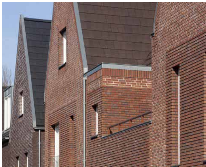
individualiteit van de woningen door kleine nuances in de gevel
