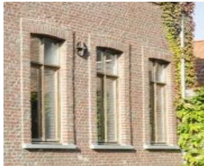
Bakstenen kader met betonen waterslagen
