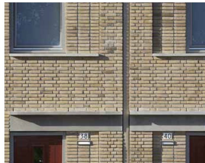
regenpijp verzonken in metselwerk
