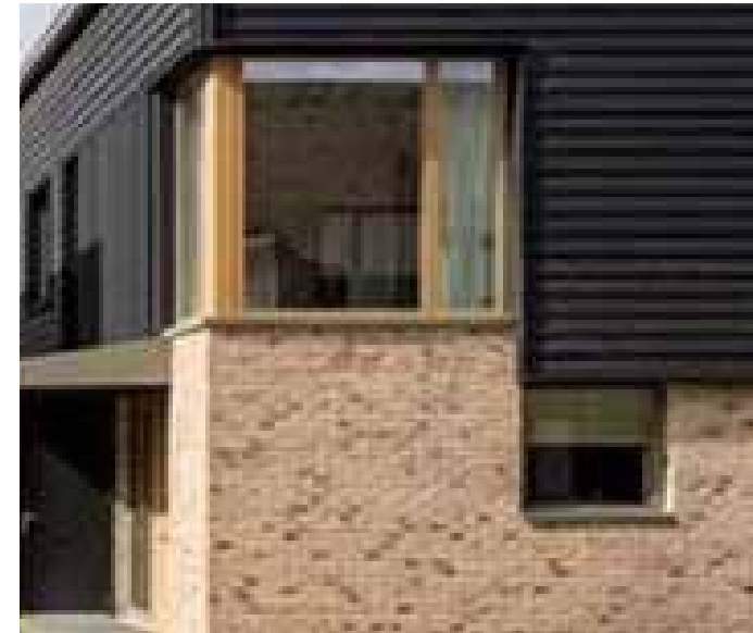
kleur kozijnen passend bij metselwerk en (zwart)hout(achtig) materiaal
