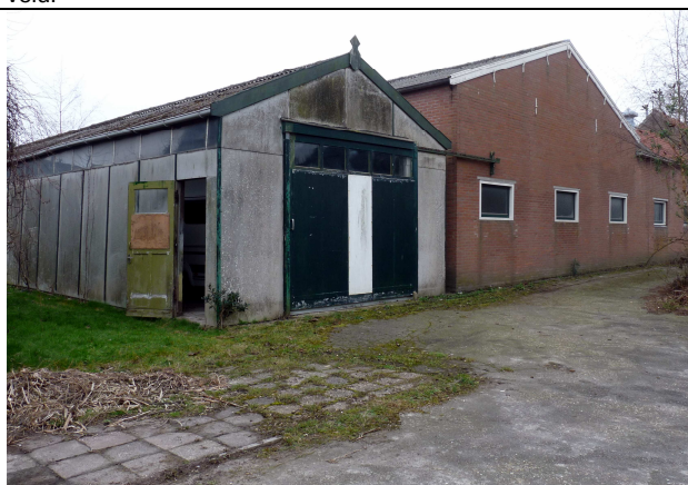
Fig. 6. Te slopen schuur op de voorgrond. De stenen werkplaats op de achtergrond van de foto blijft staan..
