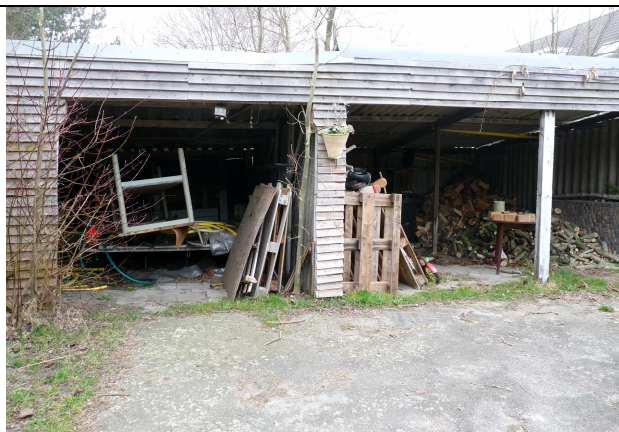
Fig. 8. Te slopen open schuren.
