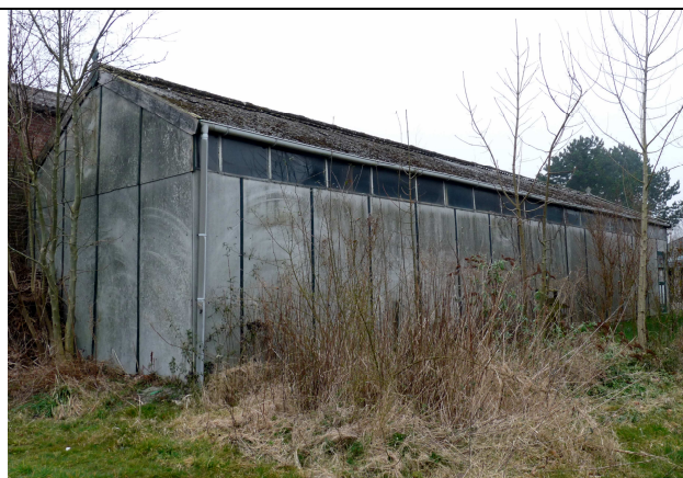
Fig. 5. Een van de te slopen schuren.
