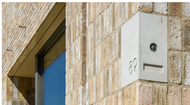
Garnituur als deurbel en brievenbus worden zorgvuldig ingepast - Strijp R, Eindhoven (bron: geurst-schulze.nl/).
