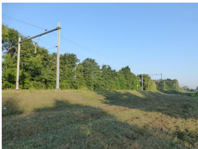
Foto 5: opgaande beplanting aan de westkant van het spoor op locatie Koningshof
