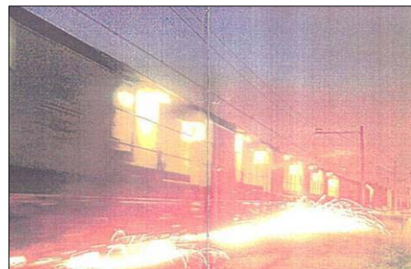
Figuur: Het bijslijpen van spoorstaven.
