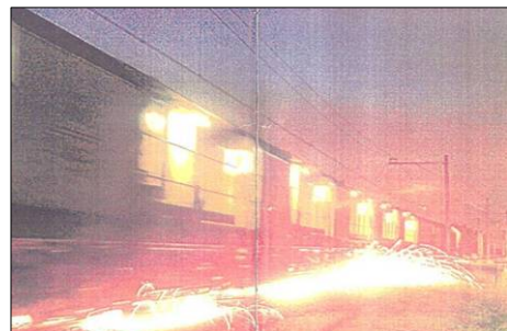
Figuur: Het bijslijpen van spoorstaven.
