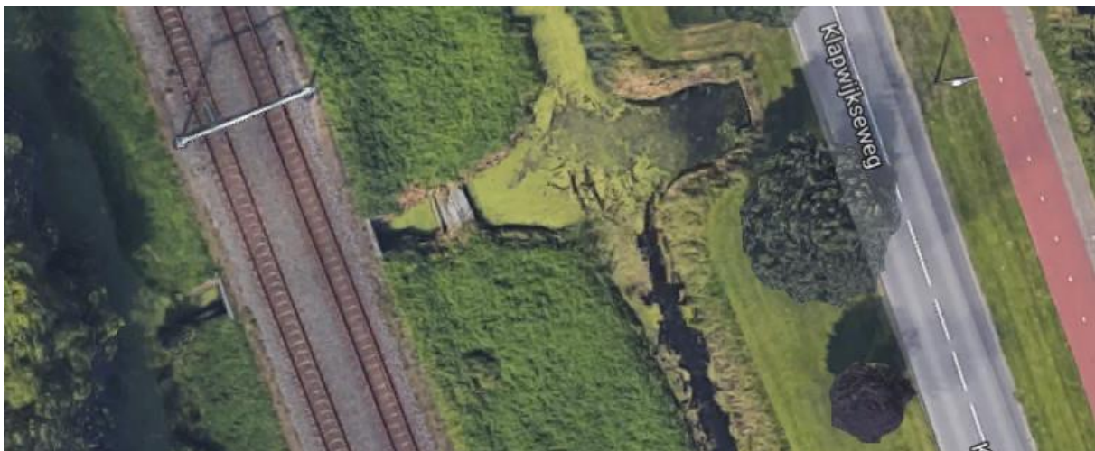
Huidig satellietbeeld met detailopname. Te zien is dat het ballastbed en dwarsliggers (beton) naoorlogs zijn vervangen.
