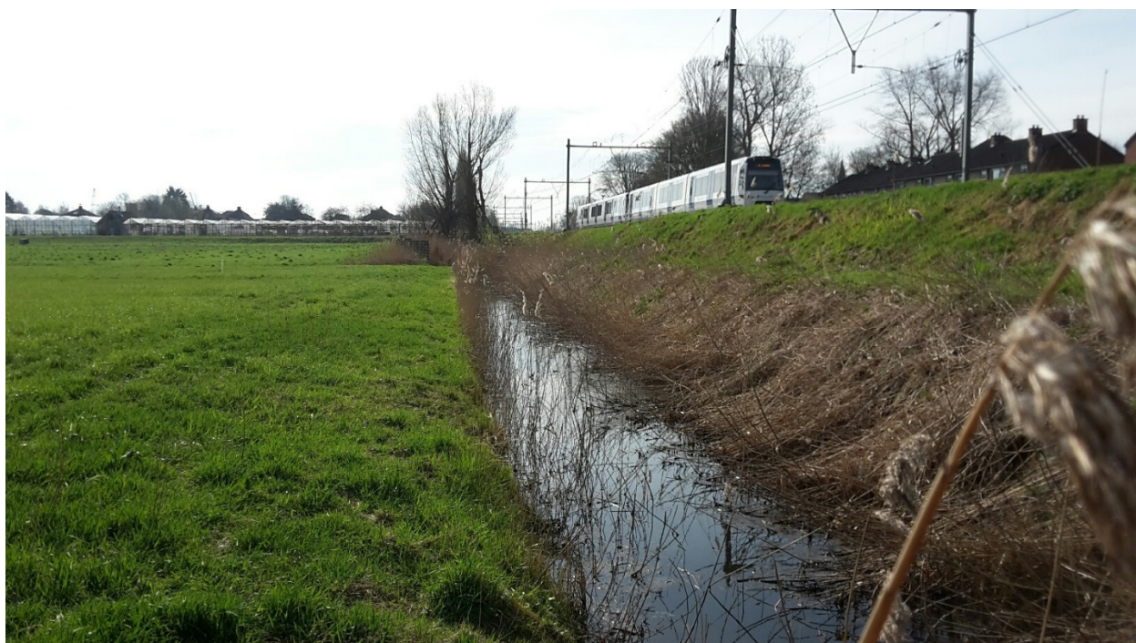
Foto 4: Watergang POL21003830 (traject S03), gezien in zuidoostelijke richting
