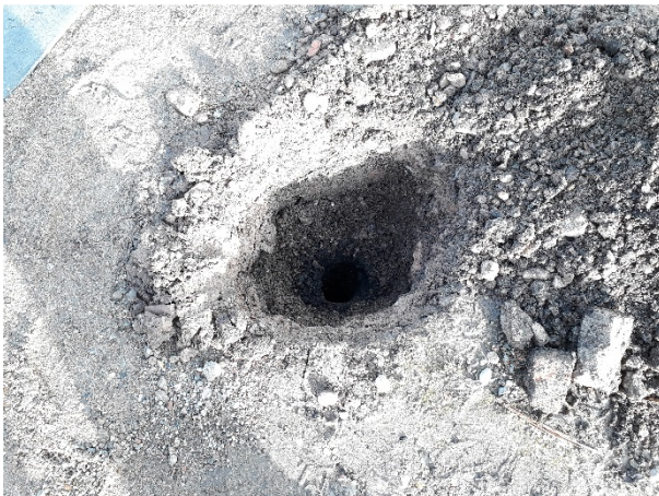
Foto 7: Proefgat 48, onderzoek asbest in puin
