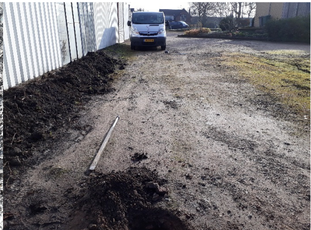
Foto 8: Proefgat 48, onderzoek asbest in puin
