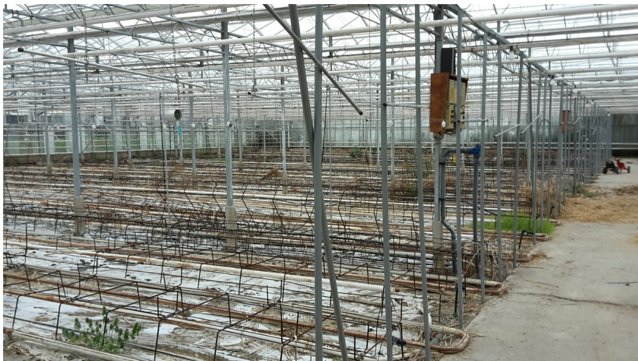
Foto 1: Kas, gezien in noordwestelijke richting
