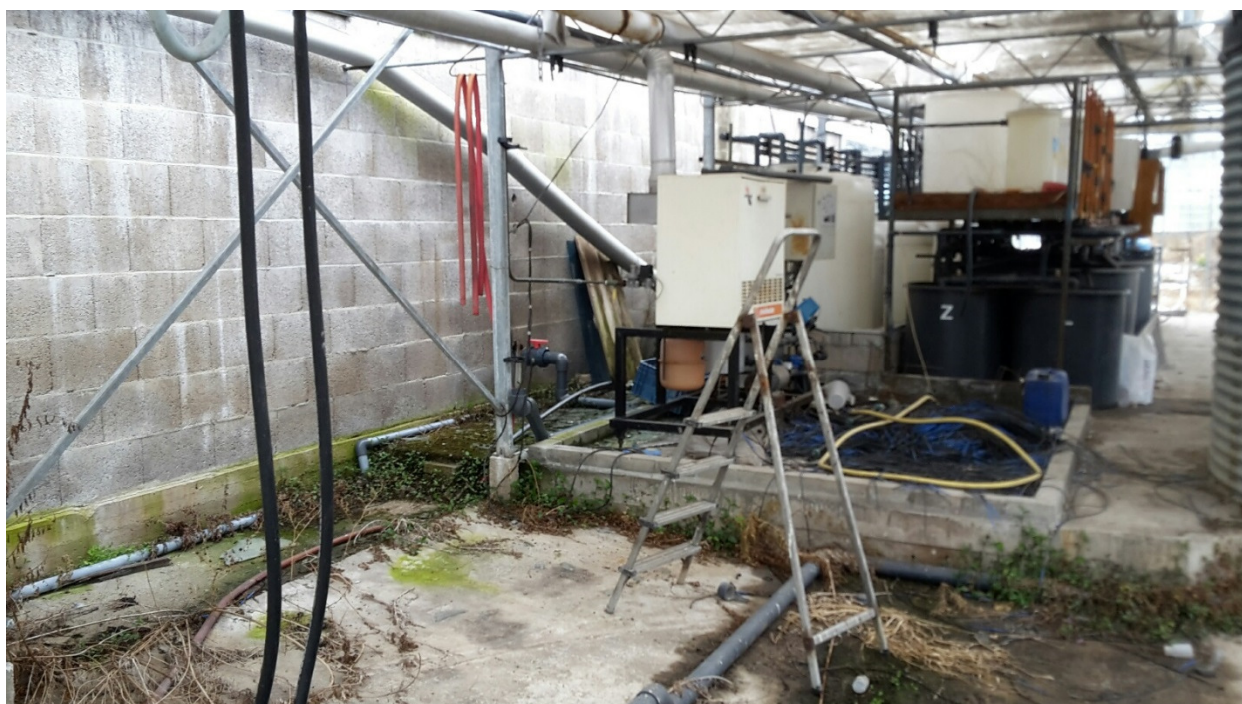
Foto 3: Substraatruimte, gezien in oostelijk richting
