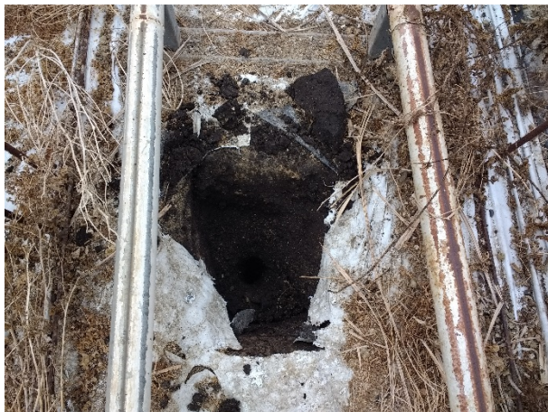
Foto 5: Proefgat 03, representatief voor het asbestonderzoek
