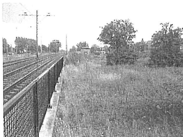
Foto 3: De noordoostelijke zijde van de onderzoekslocatie wordt begrensd door de spoorlijn Den Haag - Rotterdam. De voormalige fietsenstalling is begroeid met grassen, struiken en bomen.
