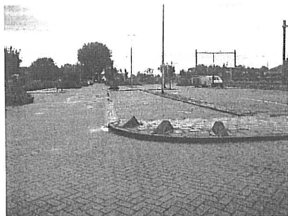
Foto 5: Het merendeel van de onderzoekslocatie is verhard met klinkers of tegels en is in gebruik als parkeerplaats.
