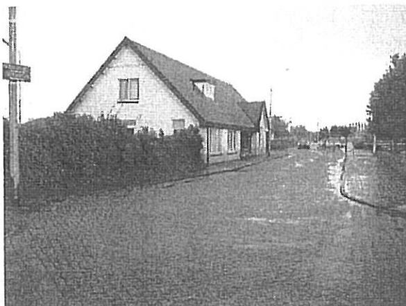
Foto 1: Het voormalig stationsgebouw aan de noordwestelijke zijde van de onderzoekslocatie.
