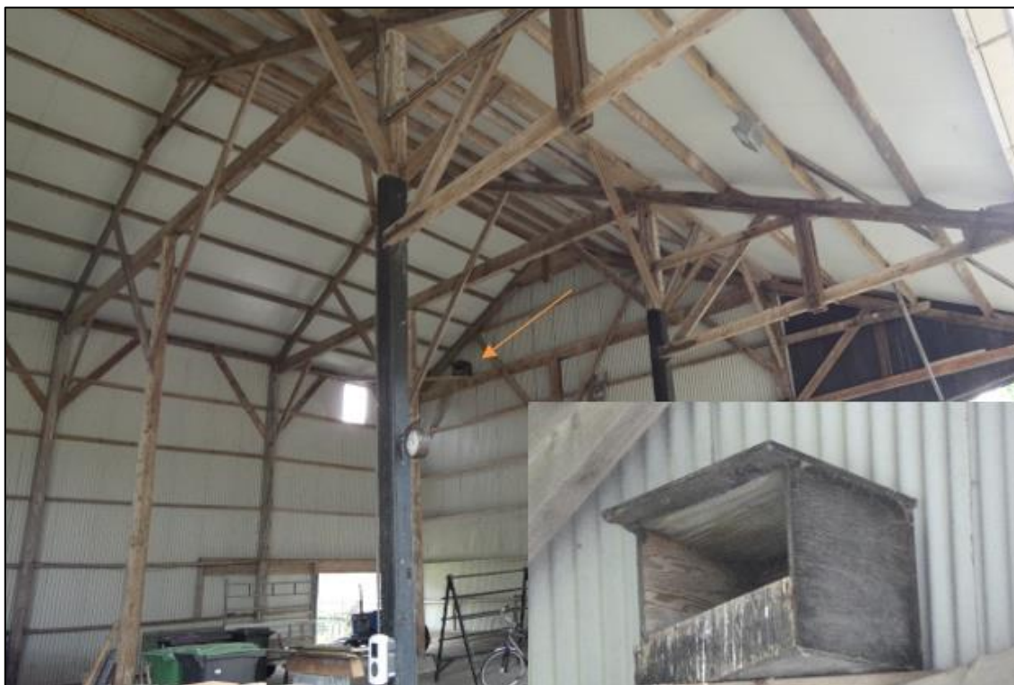
Figuur 22: In de kapschuur is een nestkast (oranje pijl) aanwezig welke door torenvalk wordt gebruikt.
