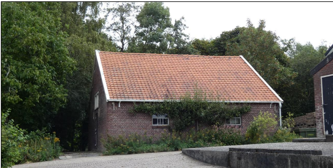
Figuur 10: De pinkenstal is opgetrokken uit baksteen en heeft een dakpannen dak.
