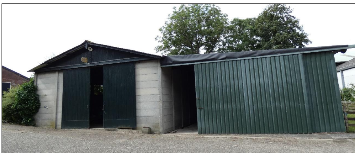
Figuur 4: De tractorschuur met aangrenzende loods zijn opgetrokken uit betonplaat en damwand en hebben een golfplaten dak. De schuifpuien (aan de oost- en zuidzijde) van de tractorschuur bestaan uit hout en het nokdeel is met hout bekleedt.
