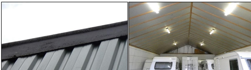
Figuur 17: Aan de opstallen met damwandplaat (te slopen aardappelschuur) zijn geen ruimten aanwezig waar vogels toegang tot een broedplaats kunnen hebben.
