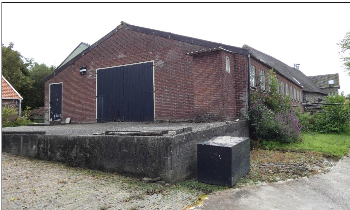
Figuur 3: De stal is opgetrokken uit baksteen en heeft een golfplaten dak.
