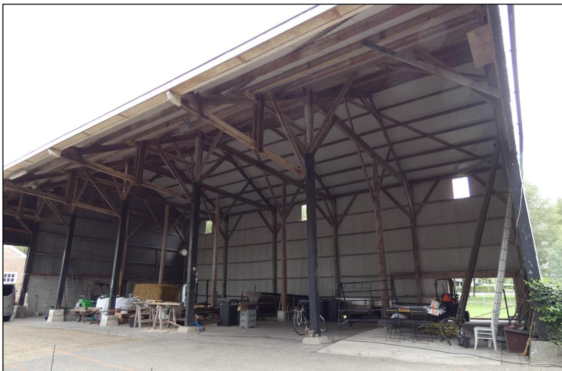
Figuur 8: De kapschuur is open aan de westzijde, heeft een houten gebinte en is volledig bekleedt met damwandplaat.
