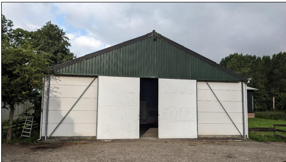
Figuur 5: De nieuwe aardappelschuur is opgetrokken uit betonplaat en heeft een golfplaten dak.
