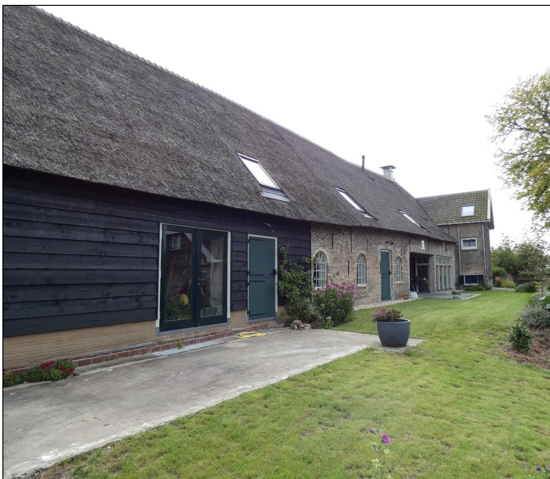
Figuur 7: De boerderijwoning. De woning heeft grotendeels een rieten dak. Enkel het dwarse deel, gelegen aan de straatzijde, heeft een pannendak.
