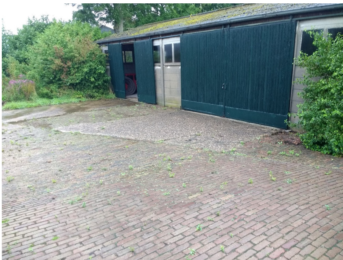
Foto 2: Zuidzijde zuidelijke loods, gezien in westelijke richting
