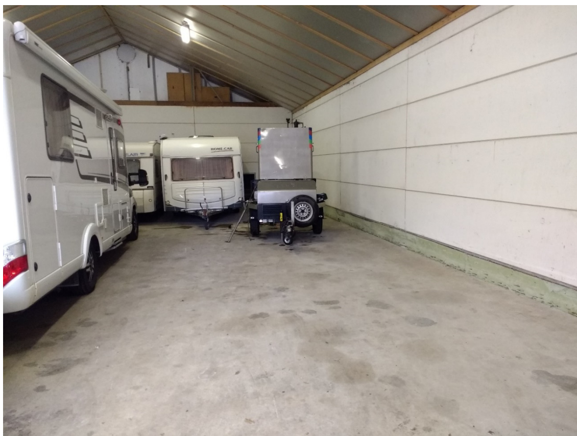
Foto 1: Noordelijke loods, gezien in westelijke richting
