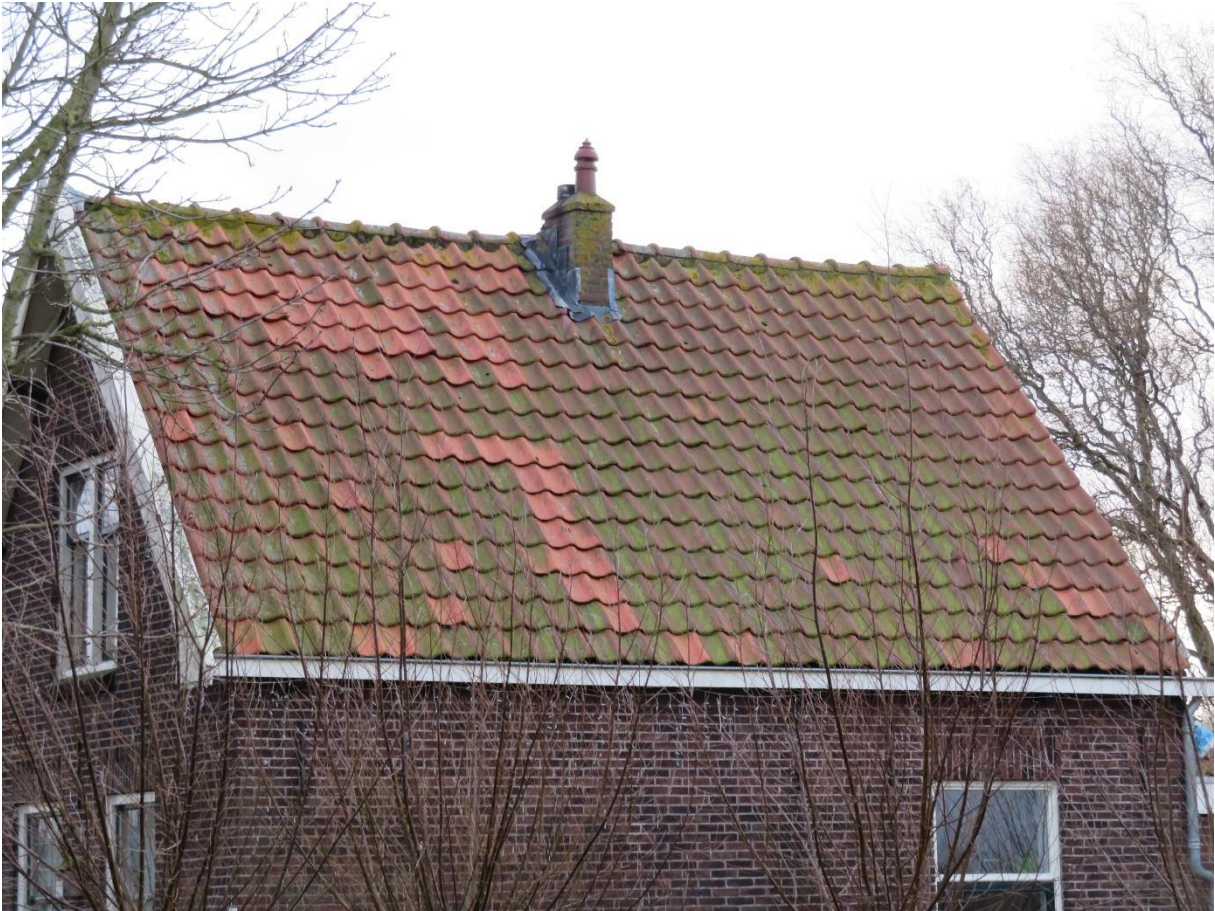
Goed aansluitende pannen op het dakvlak.
