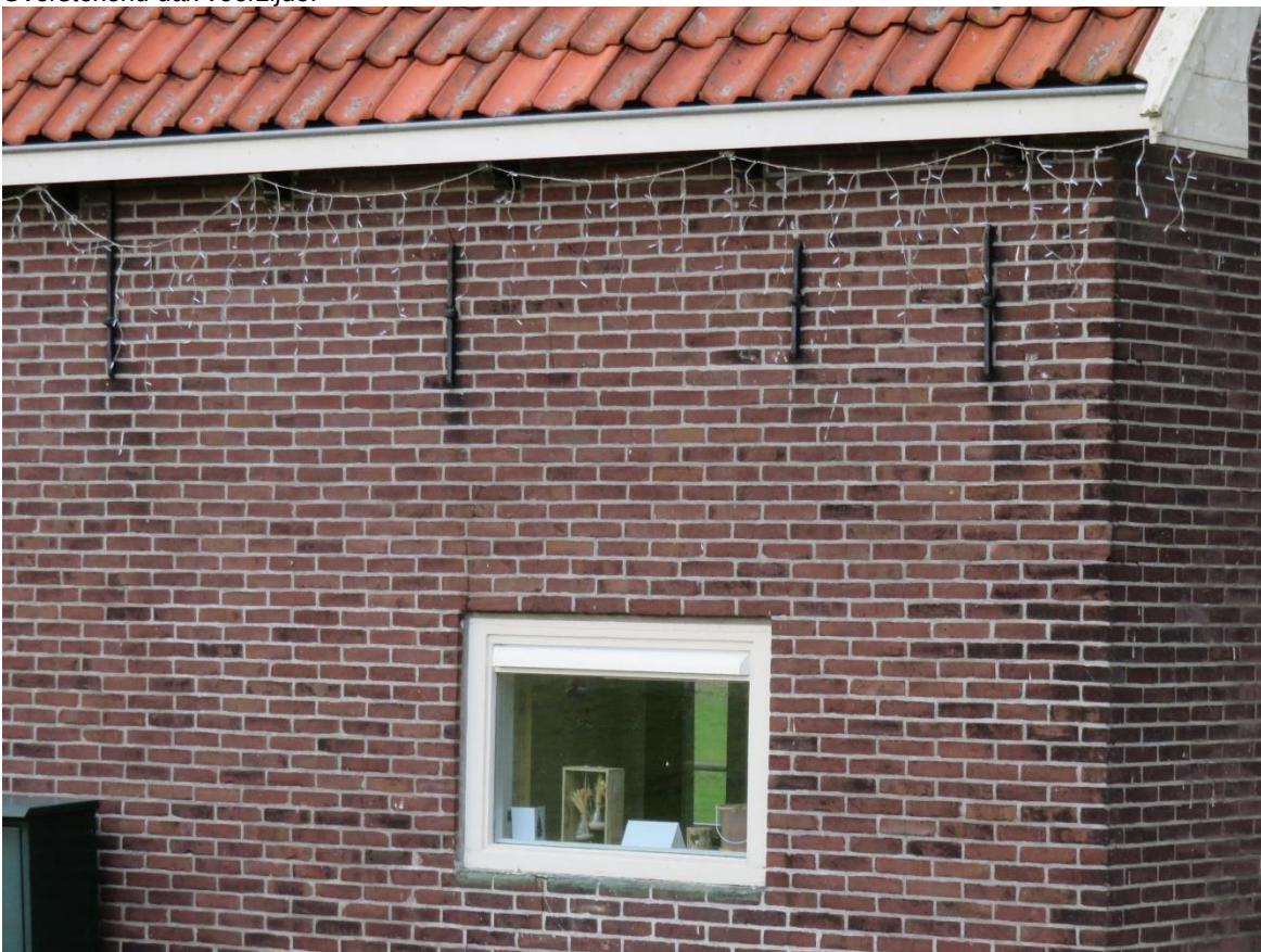
Zijgevel zonder open stootvoegen of andere kieren in de bakstenen muur.
