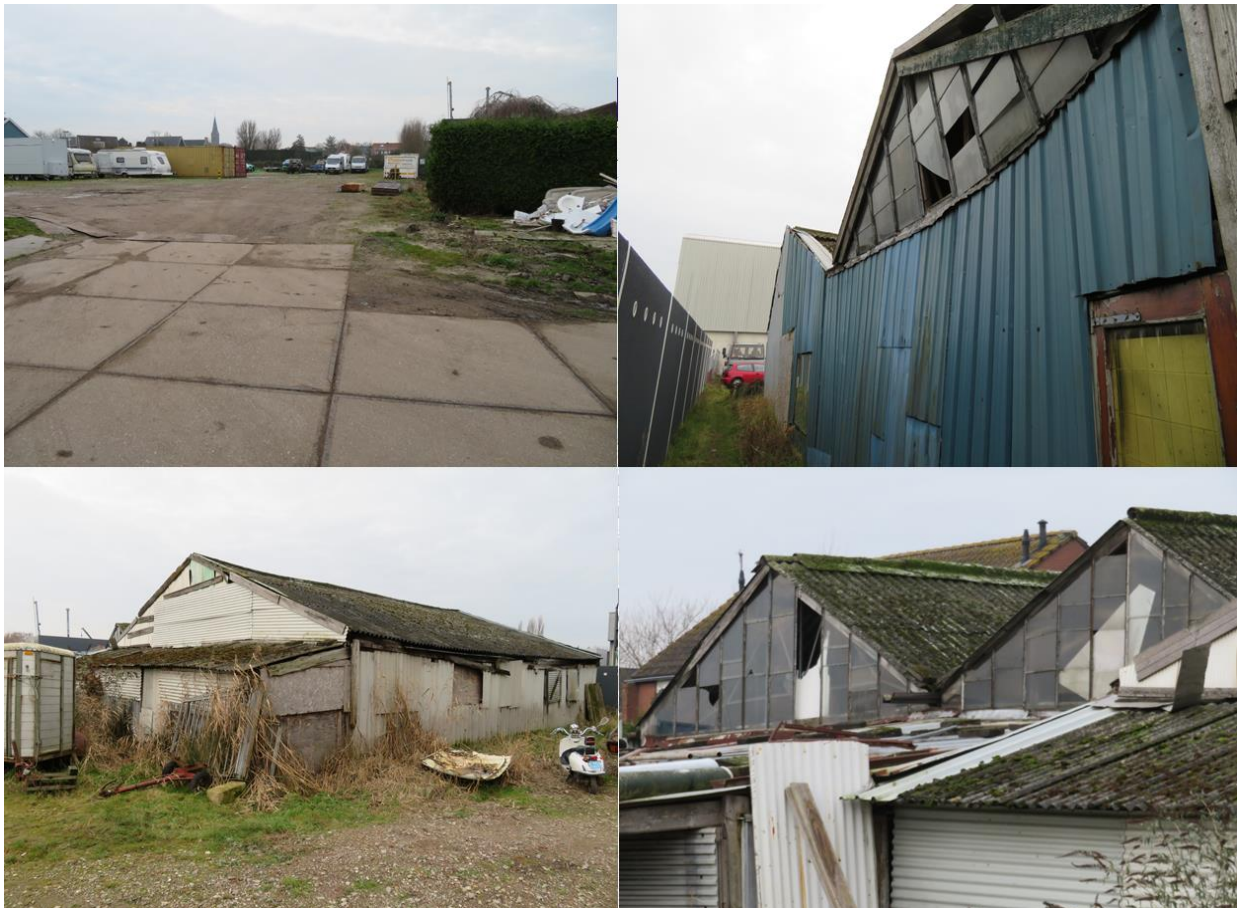
Afbeelding 4: Verharding en buitenkant schuren
