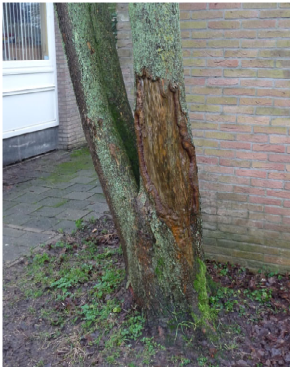
Afbeelding 4: Boom 13 met bast schade, duidt op vandalisme.
