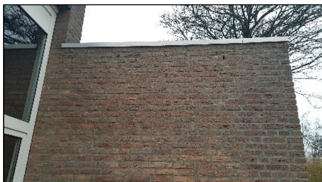
Foto 3: Enige muur met open stootvoegen binnen projectgebied.
