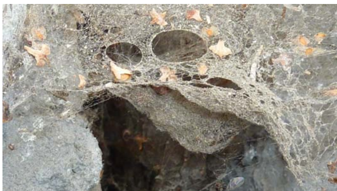
Foto 8.2. Garage NW-zijde detail 2
