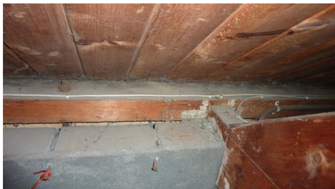
Foto 3. Spouw, muurplaat en dakbeschot
