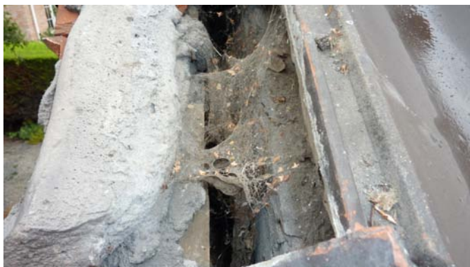
Foto 8.1. Garage NW-zijde detail 1
