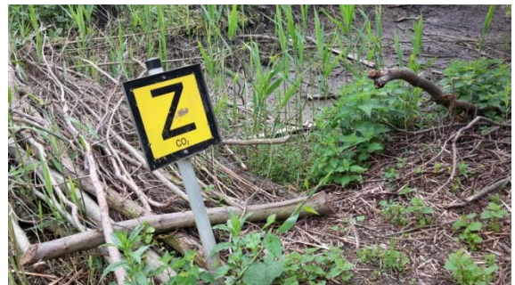
Foto 18: markering CO 2 leiding in oostelijke sloot
