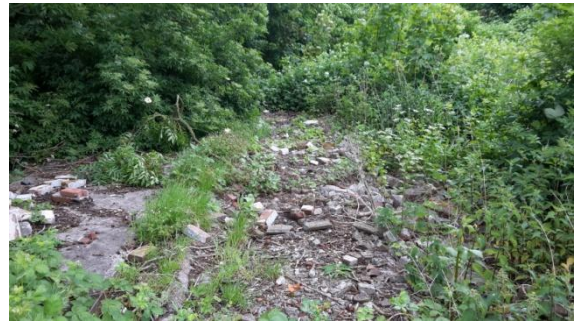
Foto 10: puin op het maaiveld zuidzijde vml boerderij,
