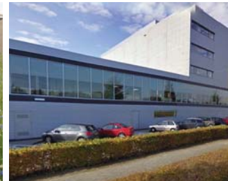
Parkeren op eigen terrein aan de kant van de Zijdeweg; auto's worden afgeschermd door hagen.
