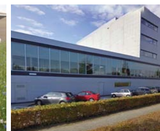
- Parkeren op eigen terrein aan de kant van de Zijdeweg; auto's worden afgeschermd door hagen.
