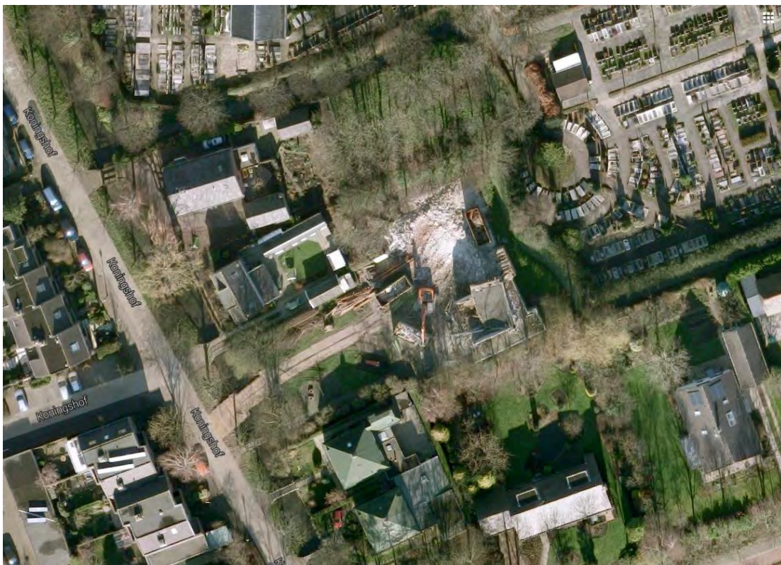
Luchtfoto van het plangebied gelegen achter de woningen Koningshof 5-7 in Pijnacker. Binnen het plangebied is de sloop van het voormalige schoolgebouw zichtbaar.
