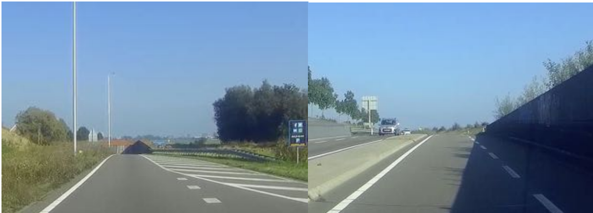
Afbeeldingen 10 en 11: Beperkt anticipatiezicht bij ingang (links) en uitgang (rechts) van de Zuidendsetunnel
