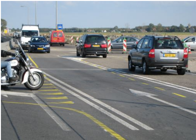
Afbeelding 5: Onduidelijke situatie door combinatie van gele en witte markering (bron: Verkeersauditors RWS)
