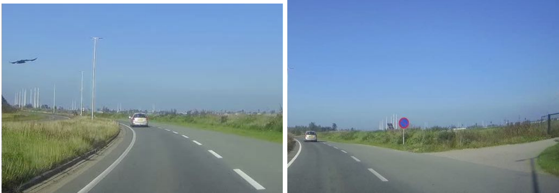
Afbeelding 18 en 19: Verwarring door kantlijnmarkering en extra asfalt.
