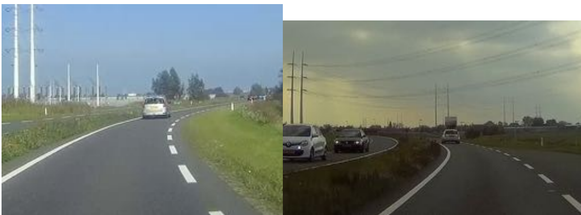
Afbeelding 20 en 21: Negatieve verkanting waardoor het rijden in een boog wordt verzwaard.
