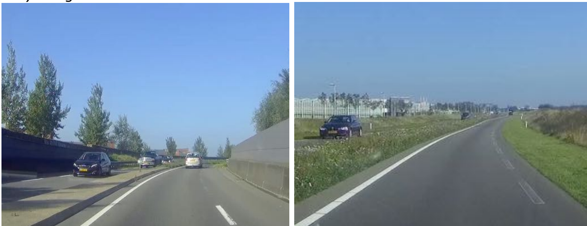
Afbeelding 16 en 17: Slijtage kantlijnmarkering bemoeilijkt inschatting wegverloop
