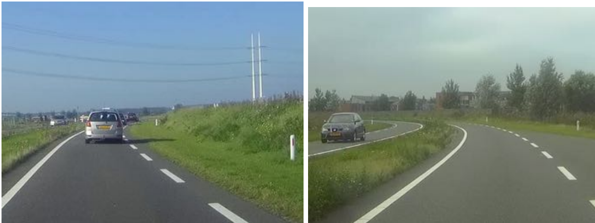
Afbbeelding 22 en 23: Reflectorpaaltjes op ruime afstand met afdekking door de berm.
