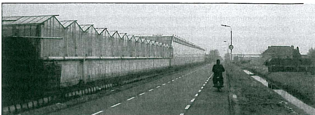
Figuur 8.3 Verschillende kastypen en hoogten, waterreservoir en woning langs een ontsluitingsweg in deelgebied Pijnacker - West
