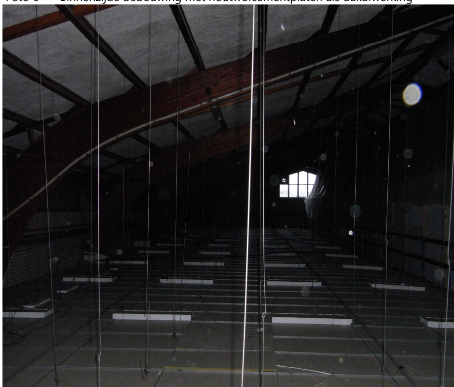
Foto 6 Binnenzijde bebouwing met houtwolcementplaten als dakafwerking
