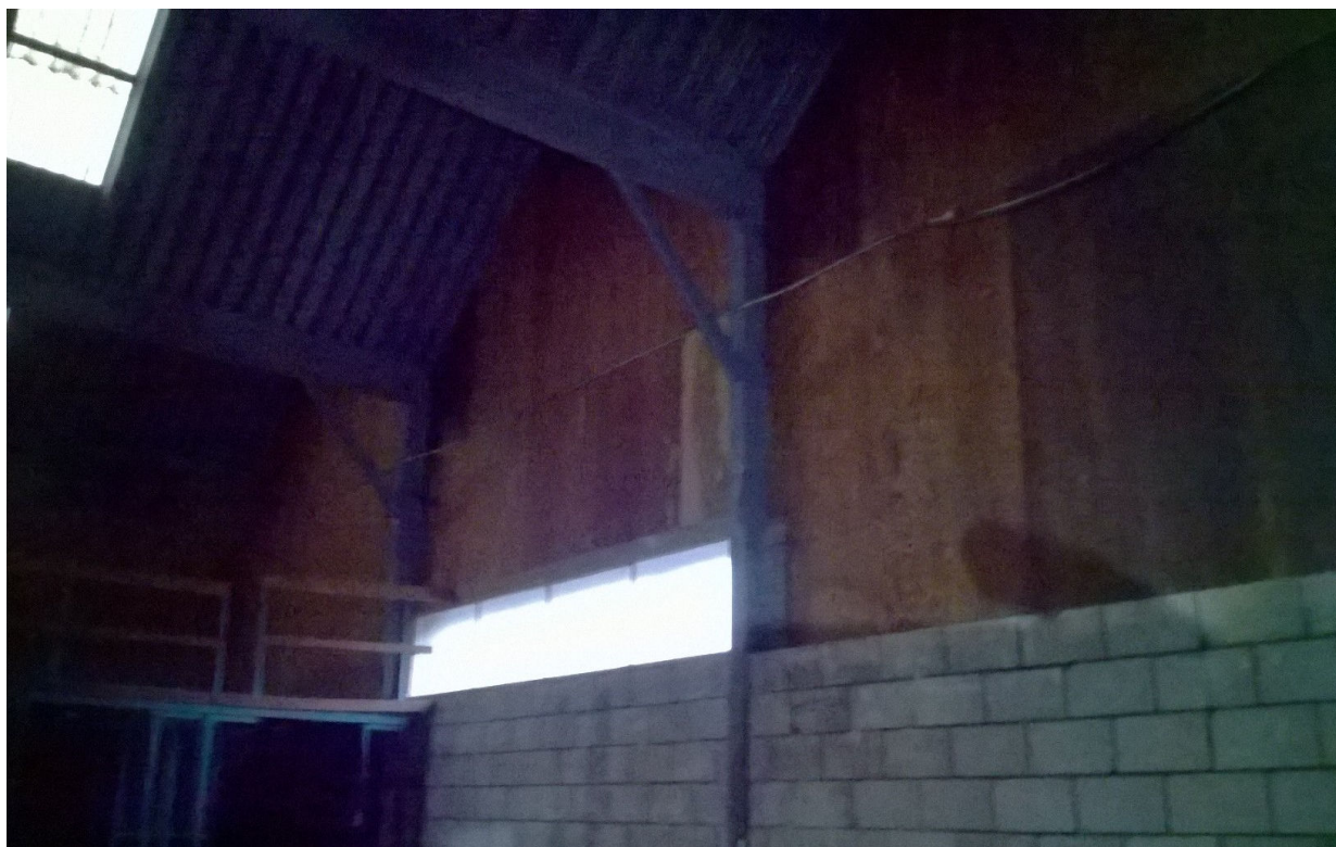
Foto 11 Magazijn aan noordzijde met houten platen afwerking van golfplaten buiten muur boven stenen muur
