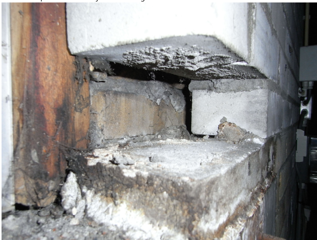
Foto 9 Spouwmuur zuidzijde bebouwing
