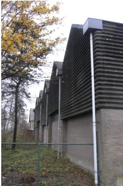
figuur 7: noordwestzijde bebouwing
