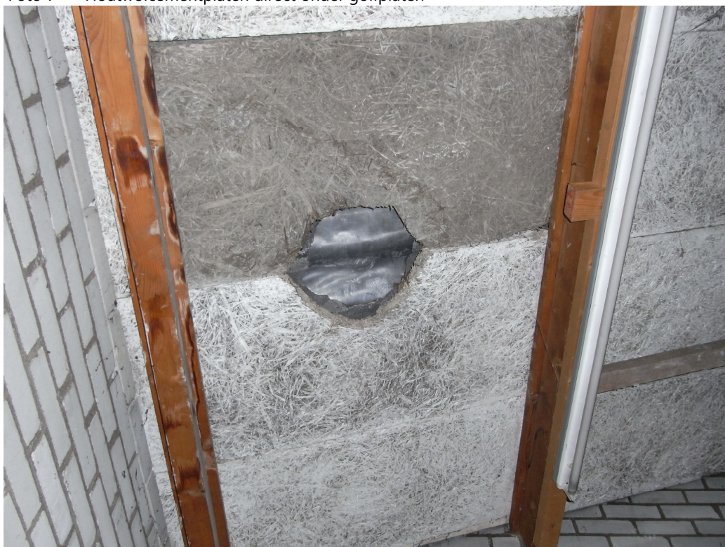
Foto 7 Houtwolcementplaten direct onder golfplaten
