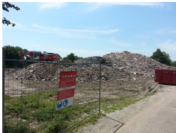
Foto 2: Puinafval van de sloop van het rusthuis
