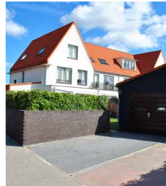
Tuinmuur gecombineerd met haag
