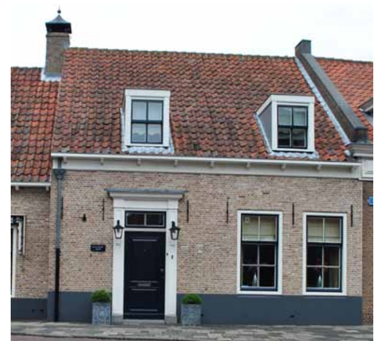
Gevel met geschilderde plint
