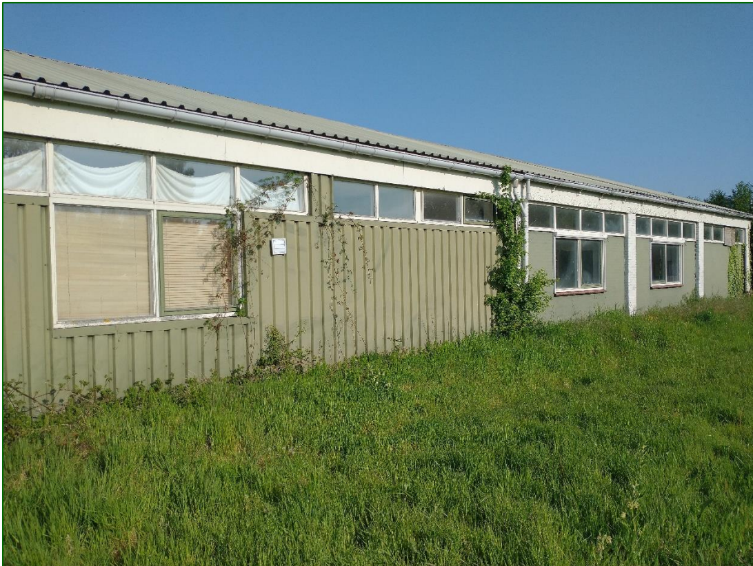
Foto 4: zijgevel aan de oostzijde van het pand. Nauwelijks geschikt voor vleermuizen of huismussen.
