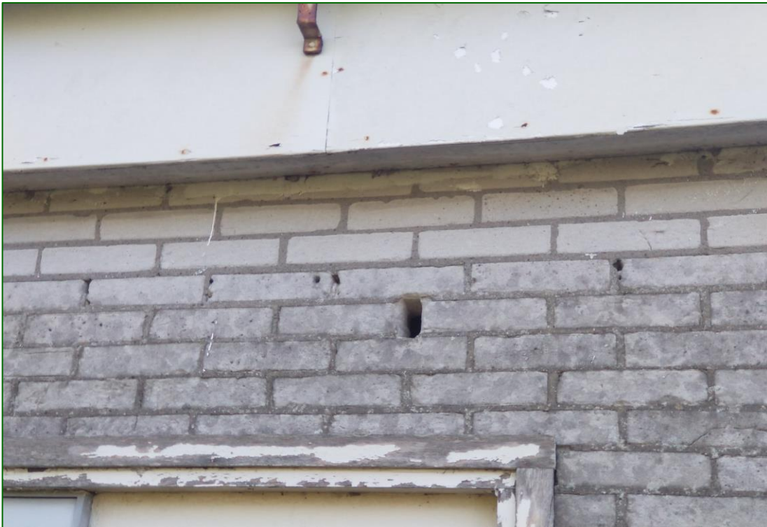
Foto 1: Voorbeeld van een stootvoeg van de schuur. Het aanvullend ecologisch onderzoek heeft aangetoond dat vleermuizen en huismussen hiervan geen gebruik maken.
